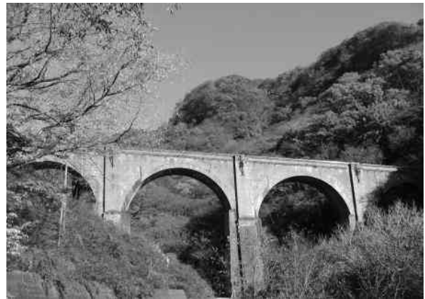
近代化遺産初の国重要文化財「碓氷めがね橋」
