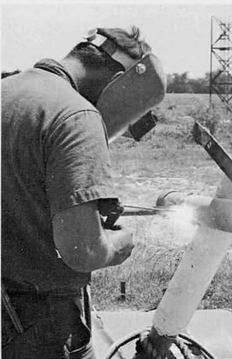
SW3 R. L. Taylor welds brace at Quang Tri gate.
