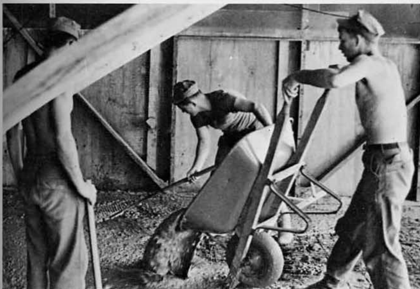
BUs pour concrete for shop floor.
